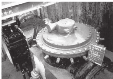
インサーバタフライ弁+割T字管M型弁体離脱式
