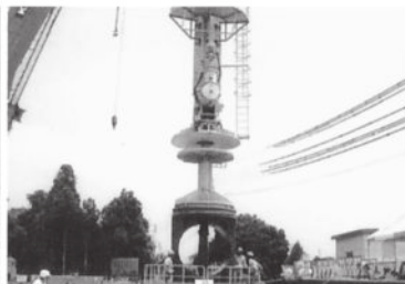
インサーバタフライ弁 取付作業
