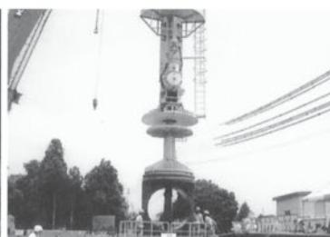
インサーバタフライ弁 取付作業
