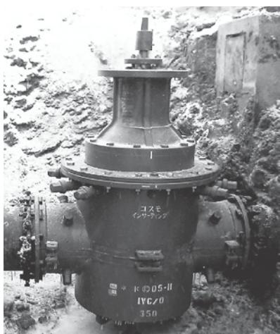
既設管の所定位置に弁箱一体形の特殊割 T 字管を設置し、インサーティング工法により、不断水用仕切弁を挿入設置します。手動減速機を取付けることができます。
