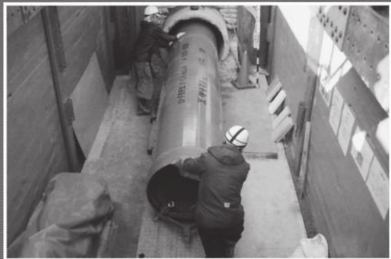
薄肉 FRPM パイプインパイプ工法
