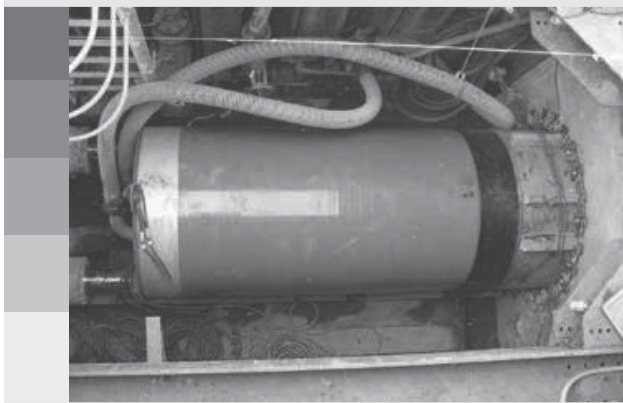
推進管 Jacking pipes
