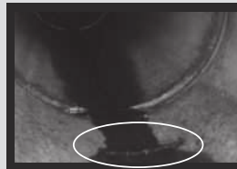
異物による 管内面の 周方向亀裂
