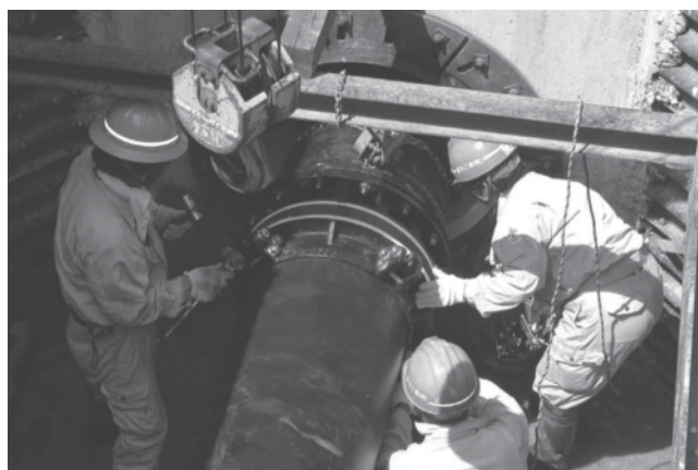
●NS形施工状況
