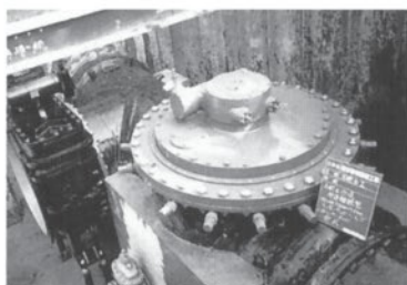
インサートバタフライ弁+割T字管M型弁体離脱式
