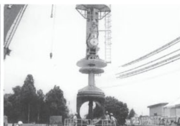
インサートバタフライ弁 取付作業
