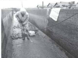
④ FRPM 板設置(側壁)
