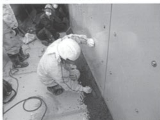
④ FRPM 板設置(側壁)
