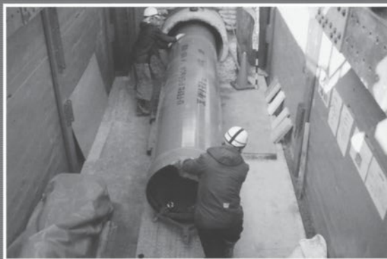
薄肉 FRPM パイプインパイプ工法
