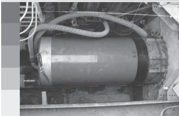
推進管 Jacking pipes
