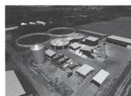
清水町美菱バイオガスプラント
