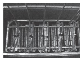
膜分離活性汚泥法
