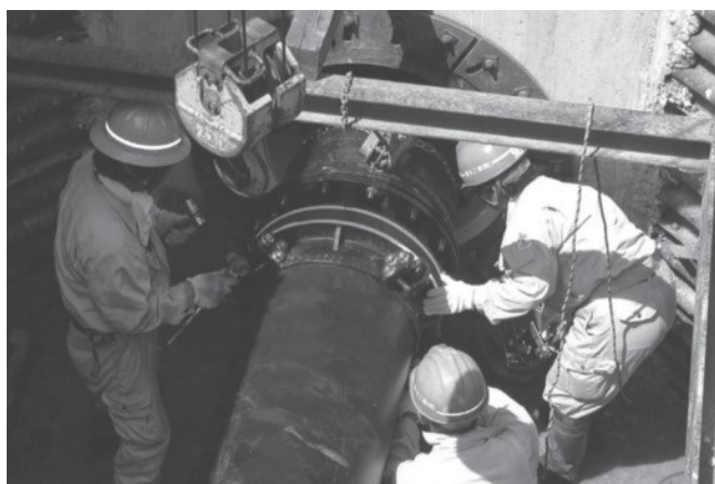
●NS形施工状況
