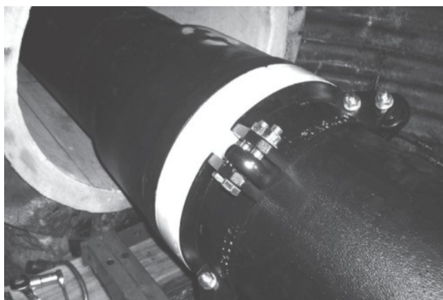
●NS形推進力伝達リング装着状況
